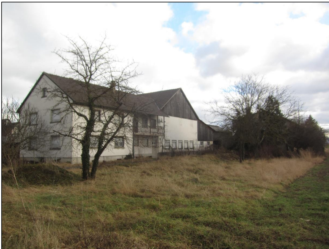
Abb. 2: Ruderalisierte Grünfläche im Norden des Untersuchungsgebietes sowie angrenzende Gehölzstrukturen und Gebäude.
