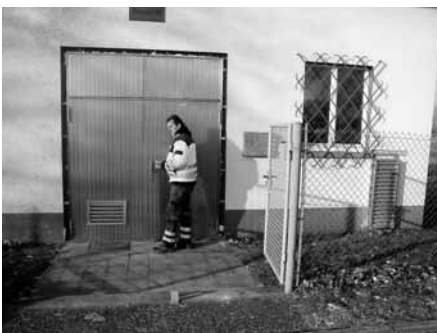
Wassermeister Harald Schmider zeigt sich sehr zufrieden über die fortgeschrittenen Sanierungsarbeiten.
