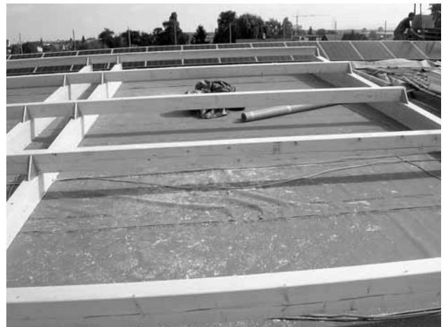
Neuaufbau des Hallendaches der Rheinmatthalle
