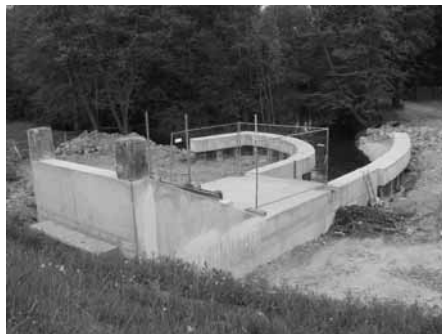
Einlauf des Mühlbachdükers am Leopoldskanal - hier ist der Treffpunkt zum Tag der offenen Baustelle
