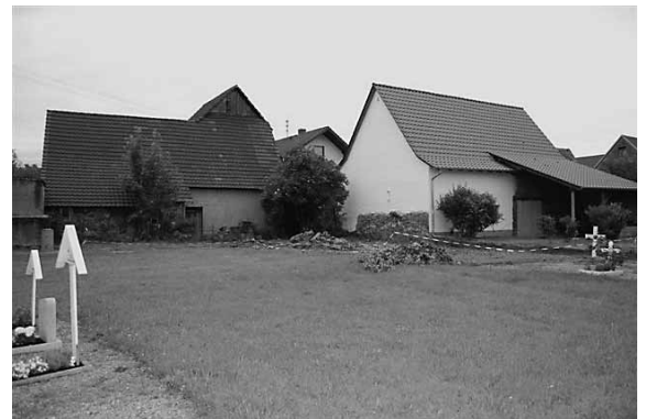
Derzeit laufen die Sanierungsarbeiten an der Friedhofsmauer in der nordöstlichen Ecke des Friedhofs Oberhausen
