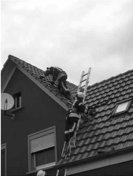
Der den ganzen Tag stark böige Wind hatte an der Gebäuderückseite eines Wohnhauses etwa 20 Dachziegel abgedeckt. Es bestand die Gefahr, dass durch den anhaltenden Sturm danach eine weit größere Dachfläche in Mitleidenschaft gezogen werden würde. Zwei Feuerwehrkameraden wurden mit dem Gerätesatz Absturzsicherung gesichert, um von einer Steckleiter aus die Dachhaut wieder zu schließen. Aufgrund anhaltender, teilweise starker Windböen waren die Sicherungsarbeiten sehr zeitintensiv.
