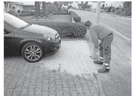
Rückbau eines Hindernisses vor einer Hofeinfahrt. Die entstandene Fläche wurde mit den selben Pflastersteinen wieder vervollständigt.
