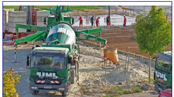
Es geht vorwärts an der Baustelle Grundschule: Anfang der Woche wurde die Bodenplatte gegossen.
