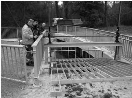
Nach gut einjähriger Testphase wurde der Rechen am Mühlbachdücker durch einen Umbau perfektioniert. Die Rechenanlage musste bisher im Schnitt dreimal pro Woche von den Bauhofmitarbeitern mit sehr großem Aufwand von Treibgut gereinigt werden, um einen konstanten Durchfluss zu erreichen. Nun wurde der alte Rechen gegen ein neues Modell ersetzt, das mit einer elektrischen Maschine nach oben bewegt werden kann. Dies erleichtert künftig die Reinigung um ein Vielfaches.
