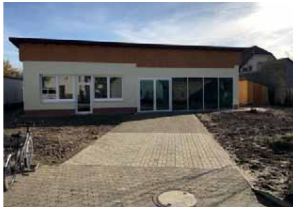
Neue Räumlichkeiten für die Realschule St. Dominikus und Aufstockung des alten Schulgebäudes
