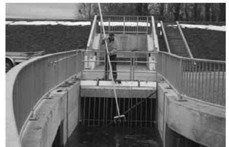
Um einen konstanten Durchfluss zu erreichen, muss zweimal pro Woche die Rechenanlage am Mühlbachtücker durch unsere Bauhofmitarbeiter gereinigt werden. Die Reinigung der Rechenanlage liegt im Zuständigkeitsbereich der Gemeinde.
