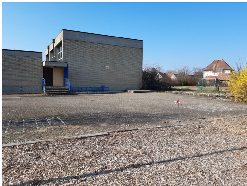
Foto 2: Ehemalige Schwimmhalle mit Rammpegel KB 2 am 07.03.2022
