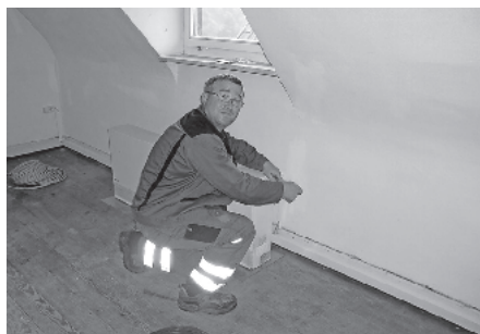
Der Elektriker des Bauhofes beim Verlegen und Anschließen der neuen Elektroinstallation.
